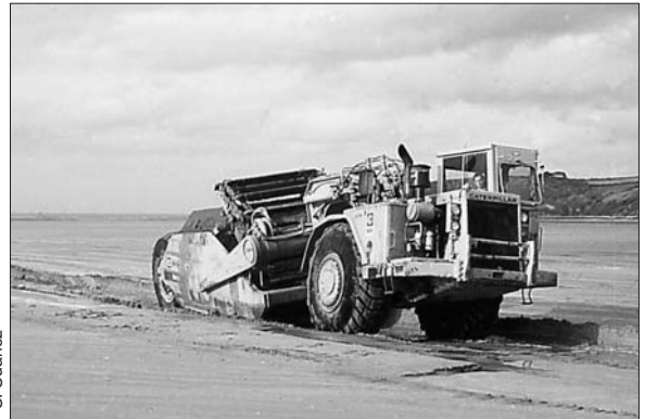
Ouverture du chenal artificiel du Yar à l'aide d'un engin de type "époucheur".
