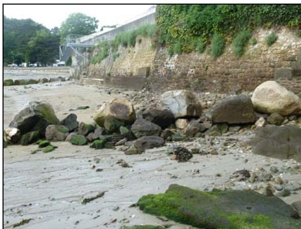
Photo n° 10: ajout inutile de blocs disjoints sur l'épi n° 2 au printemps 2012
