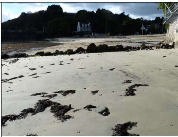
*Photo n° 7 : L'épi n° 1 le 28 octobre 2011. Noter les seuils, l'irrégularité de la cote d'arase. De plus l'angle de la photo masque une partie des défauts de ce type.*
