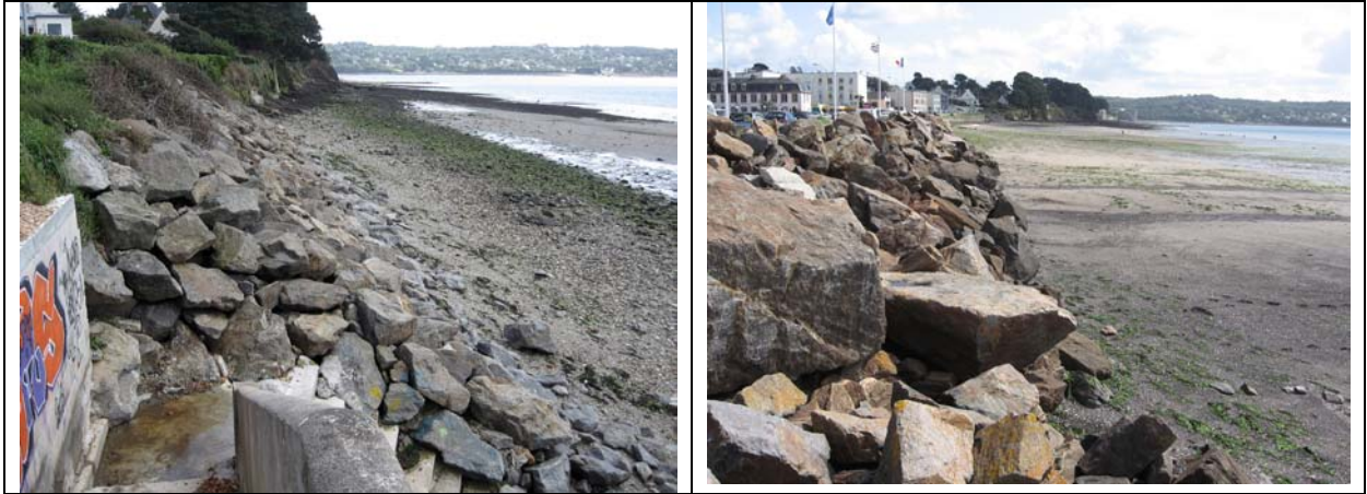
Photo 3 : Granulométrie de l'estran au niveau de l'enrochement est. Noter la présence de blocs à mi-estran
