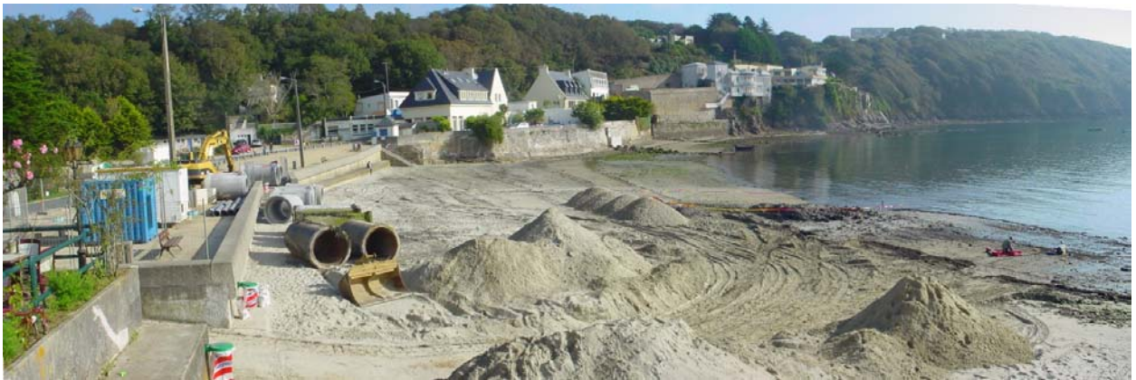
Figure 16 : travaux de rallongement de la buse du ruisseau de Sainte-Anne en octobre 2007
