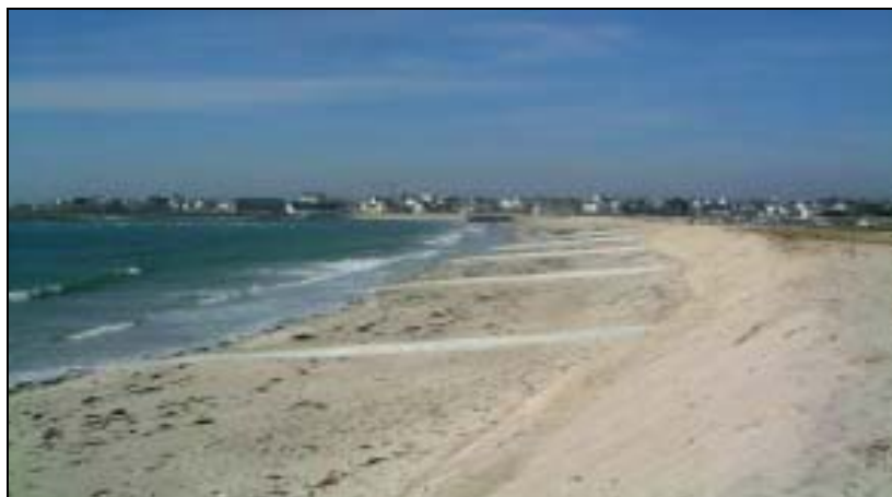
Photo 2 : Vue oblique prise au sol des Stabiplate® (source : Espace Pur)
